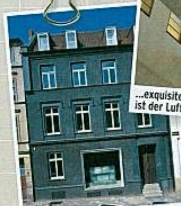
Stadthaus in Schwerin, 2004 clever renoviert. Unten Büro und darüber...
